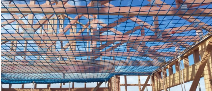
Şekil 15: Çatı işinde güvenlik ağı kullanımı
