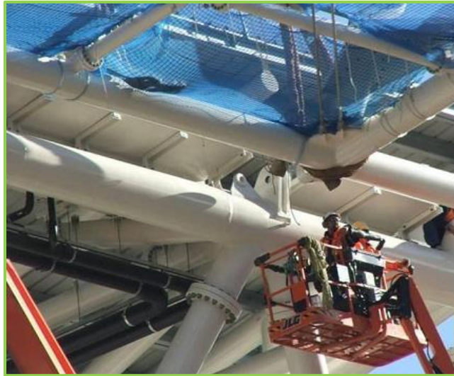
Şekil 18: Yükseltilebilir iş platformu aracılığıyla güvenlik ağı kurulumu
