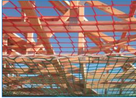
Şekil 21: Ağların birleştirme ipi ile bir araya getirilmesi
