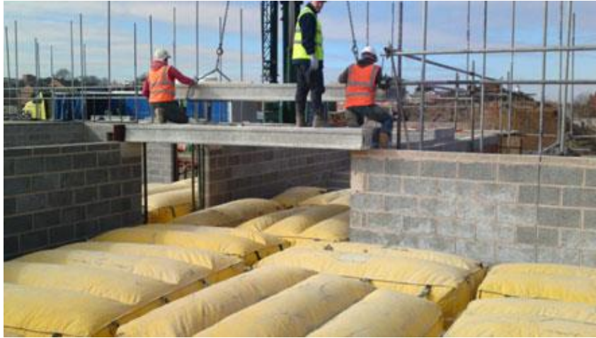
Şekil 2: Düşmeye karşı hava yastıklarının kullanımı
